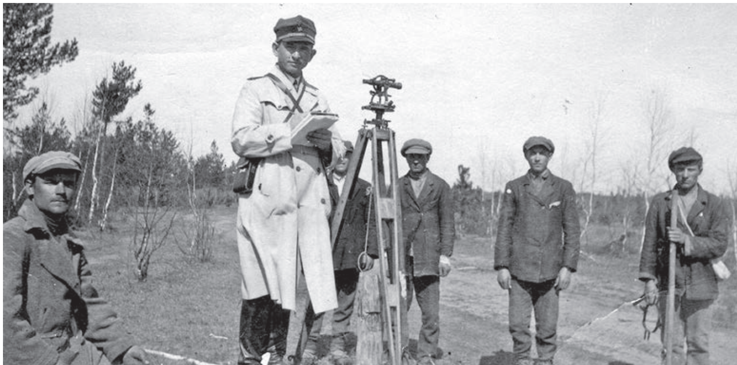
MIERNICZY URZĘDU ZIEMSKIEGO PRZY PRACACH POMIAROWYCH
