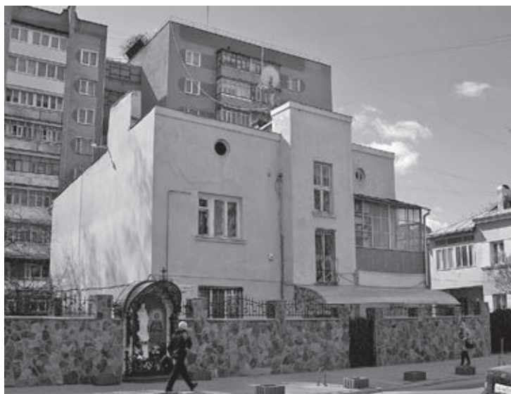
TAK PRZED REKONSTRUKCJĄ WYGLĄDAŁA WILLA HANSA KRÜGERA
