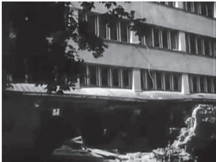
ZNISZCZONY GMACH POCZTY
